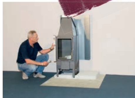
Ustawić wkład kominkowy za pomocą poziomicy. (3)
