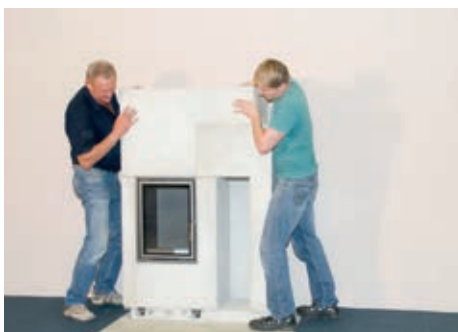
Wystarczy postępować zgodnie z dołączoną instrukcją i złożyć wszystkie części. Przymocuj je na miejscu za pomocą kleju akrylowego. (4+ 5)
