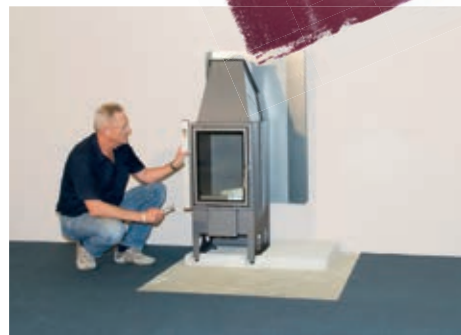
Ustawić wkład kominkowy za pomocą poziomicy. (3)
